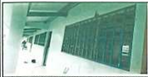
Foto 5: INTERIOR DELAS AISLAS CON SUMINISTRO E INSTALACIÓN DE LÁMINAS FINALIZADO
