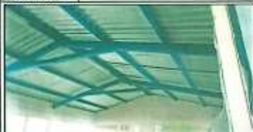
Foto 1: VISTA FACHADA INTERIOR LÁMINA COLOCADA AL 100%
