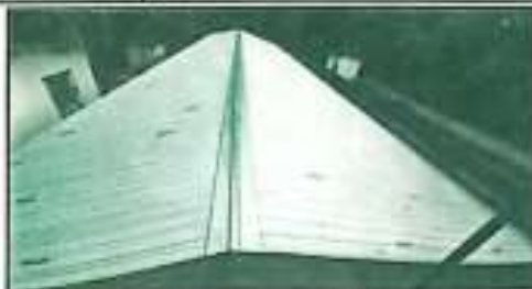
Foto 2: VISTA DE INSTALACIÓN DE LÁMINA FINALIZADO
