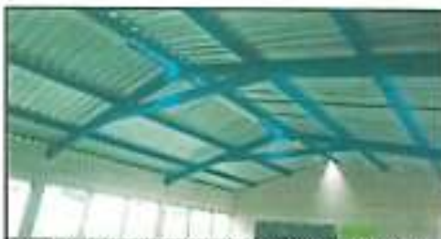
Foto 6: INTERIOR DELAS AISLAS CON SUMINISTRO E INSTALACIÓN DE LÁMINAS FINALIZADO
