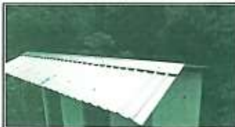
Foto 4: VISTA ANGULO LADOS DE SUMINISTRO E INSTALACIÓN DE LÁMINAS
